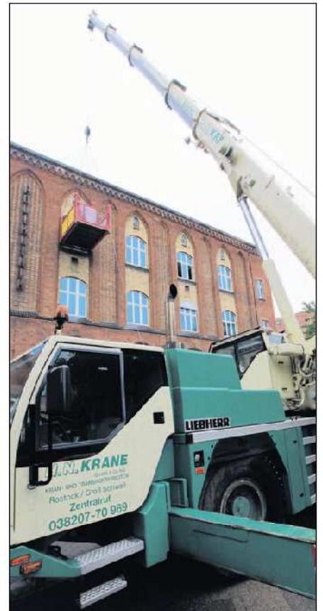
Sogar ein Fenster wurde ausgebaut für das Einschweben des neuen Computertomographen im Ärztehaus am Frankenwall. Foto: H. E.
